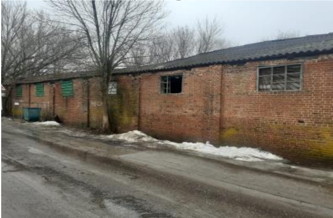
Здание склада, кадастровый номер 31:25:0803036:453
