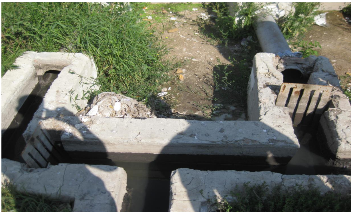
Рисунок 3. Песколовки
